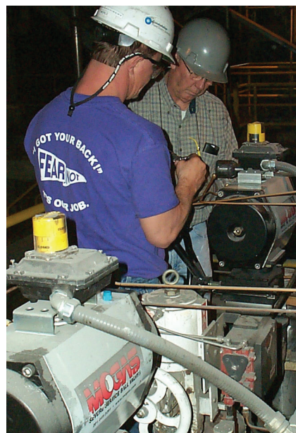
Estas cuatro válvulas de bola GEN-X MOGAS de 2 pulgadas se manejan en aislamiento de recalentamiento en frío en una planta de combustión de carbón.
