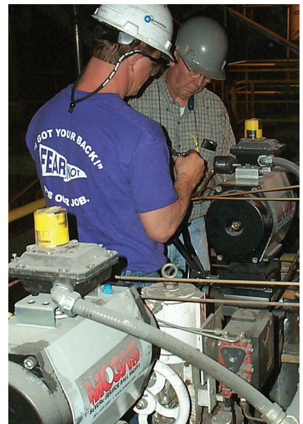
Ces quatre vannes à boisseau sphérique GEN-X MOGAS de 2 pouces assurent l'isolement de la post-combustion à froid dans une centrale au charbon.
