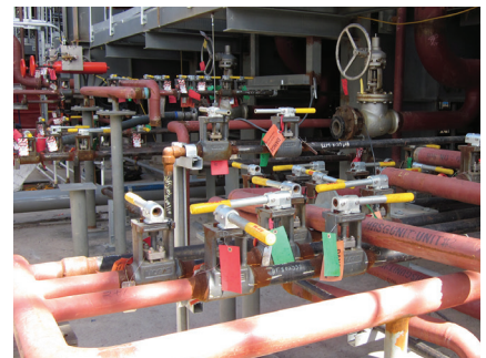
Cette installation de traitement de gaz naturel à cycle combiné récemment construite bénéficiera de l'efficacité des vannes MOGAS iRSVP au niveau des conduites et événements de son générateur de vapeur à récupération de chaleur (HRSG).
