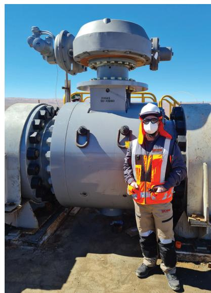
**Quatro válvulas MOGAS Série T (trunnion) de 36 polegadas, Classe ASME 900, foram instaladas para atuar em operações de cobre em um deserto remoto no Chile.**
