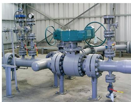
*Esta estação de bombeamento de hidrotransporte tem válvulas de esfera de metal MOGAS de 6 e 8 polegadas, classe ASME 1500, bem como muitas válvulas de drenagem de 2 polegadas, classe ASME 1500, que estão em operação desde 1994.*
