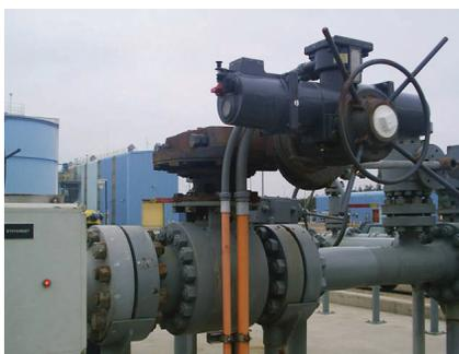
Várias válvulas da Série C de 8 polegadas, Classe ASME 1500, atuam 28 vezes por mês com diferencial de pressão para isolar com sucesso a polpa de cobre.
