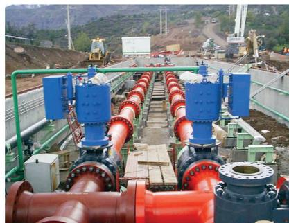
**Essas válvulas de esfera com classificação ASME 900 de 24 polegadas em uma estação de estrangulamento tem um tempo de deslocamento de 45 segundos para manusear o concentrado de cobre com uma taxa de fluxo média de 1.167 litros/segundo.**
