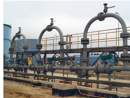
Estas válvulas de lodo o concentrado de cobre Clase ASME 900 de 20,32 cm (8 pulgadas) han completado aproximadamente 40 ciclos al mes contra 1 500 libras por pulgada cuadrada.
