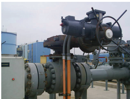
Múltiples válvulas de la serie C, de 20,32 cm (8 pulgadas), Clase ASME 1500, realizan 28 ciclos al mes bajo presiones diferenciales para aislar con éxito el lodo o concentrado de cobre.
