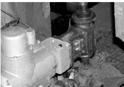
这个 ASME 4500 磅级 IRSVP 对流排气阀被设计为用来处理锅炉中所放出的极端高压和高温。
